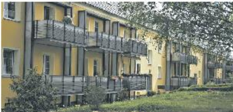
Zu den Woba-Beständen gehört auch dieser sanierte Wohnblock in der Windmühlstraße in Dresden-Proitzsch.
