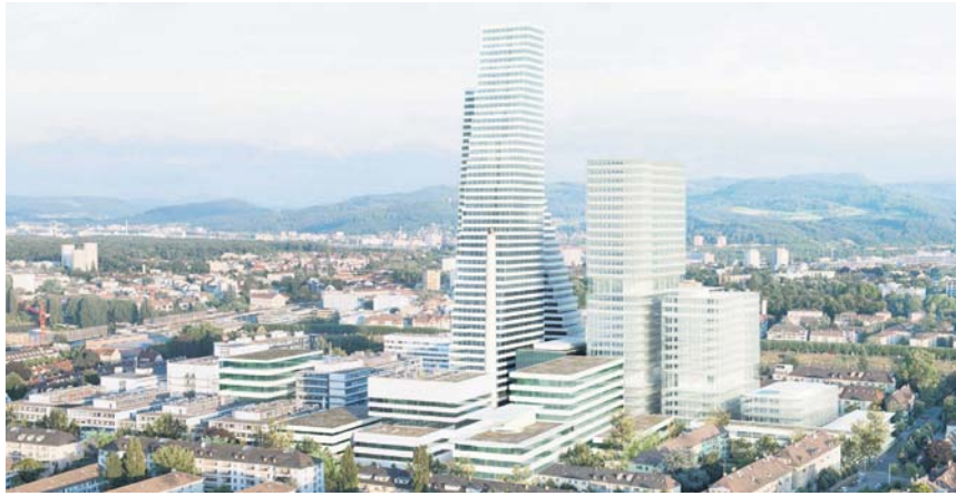
Spätestens ab 2022 wird das Roche-Areal die Silhouette von Basel beherrschen und darüber hinaus das größte Schweizer Hochhaus stellen. Bild: Roche
