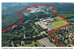
Hinrich-Wilhelm-Kopf-Kaserne 27478 Cuxhaven / Altenwalde Hinrich-Wilhelm-Kopf-Straße Grundstücksgröße: ca. 75,2 ha Ein Energieausweis ist nicht vorhanden. Es wird um Abgabe eines Angebotes gebeten.
