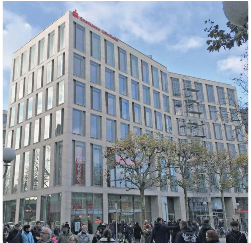
Das Sparkassengebäude am Friedensplatz zählt zu den wenigen Bürobauten, die kürzlich fertiggestellt wurden. Bild: thk
