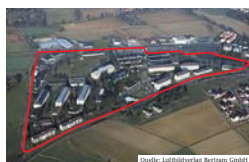
Künftiges Wohn- u. Gewerbeareal 63654 Büdingen Lorbacher Straße Grundstücksgröße: ca. 18 ha Die Energieausweise sind beauftragt. Es wird um Abgabe eines Angebotes gebeten.
