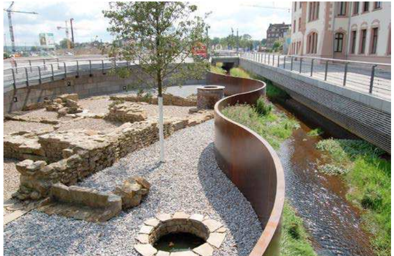
Mit dem Umbaukonzept Hörder Bach entstanden erlebbare Natur- und Kulturräume in der Stadt (Gewinner des DWA Gewässerentwicklungspreises 2013). U. a. wurde eine freigelegte Ausgrabungsstätte in die Gestaltung integriert. (Foto: Emschergenossenschaft)
