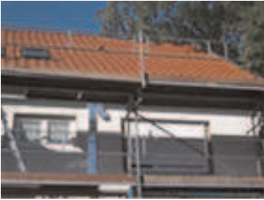
Bild 23: Flacher Fortluftkanal auf der Fassade vor dem Aufbringen der Wärmedämmung
